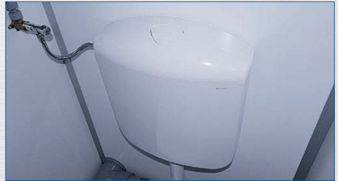
Spülkasten mit Sparfunktion
